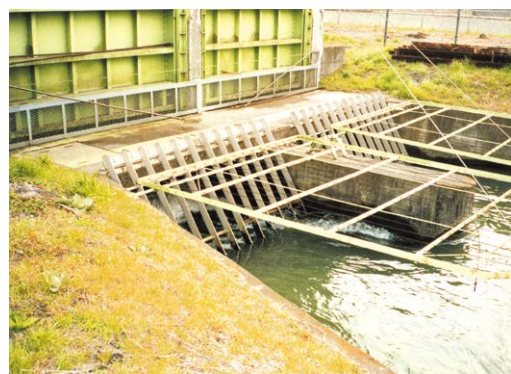
用水路のスクリーンパネル
