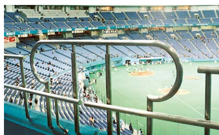
手すり(京セラドーム大阪)
