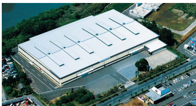
東関東配送センター
