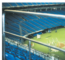
手すり (東京ドーム)
