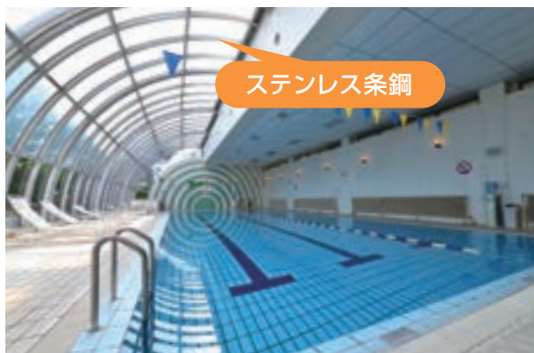
温水プールのステンレス上屋/ANAクラウンプラザホテル成田
