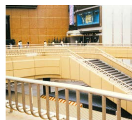
歩道橋の手すり
