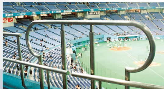
手すり(京セラドーム大阪)
