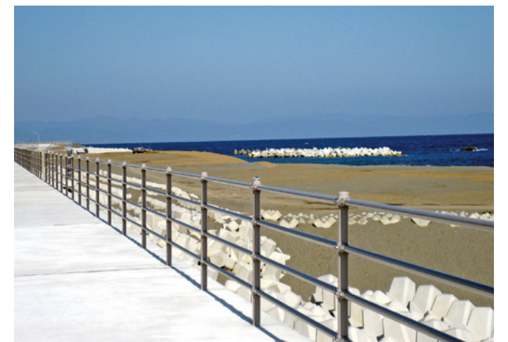
フェンス（メッキ管）
