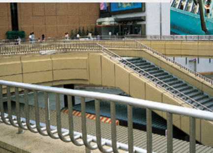
歩道橋の手すり
