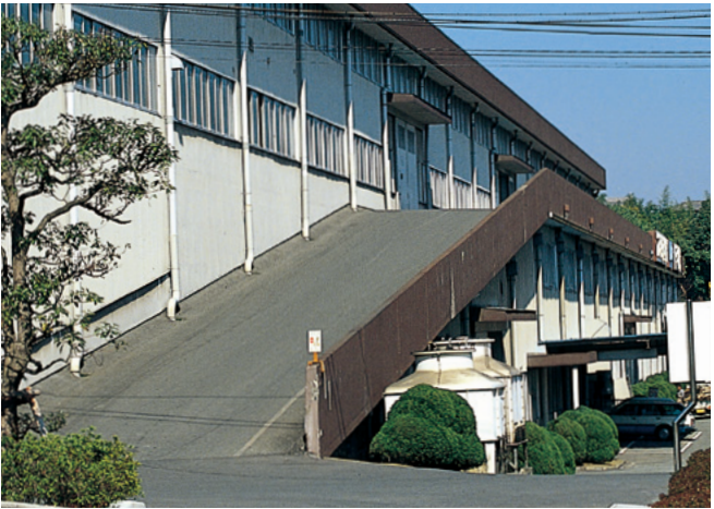
工場建屋は大部分2～3階建て
