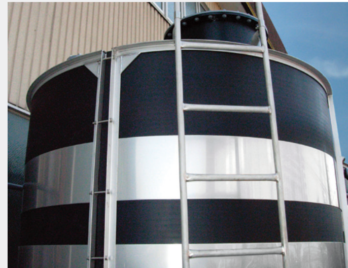
貯蔵タンクの補強材
